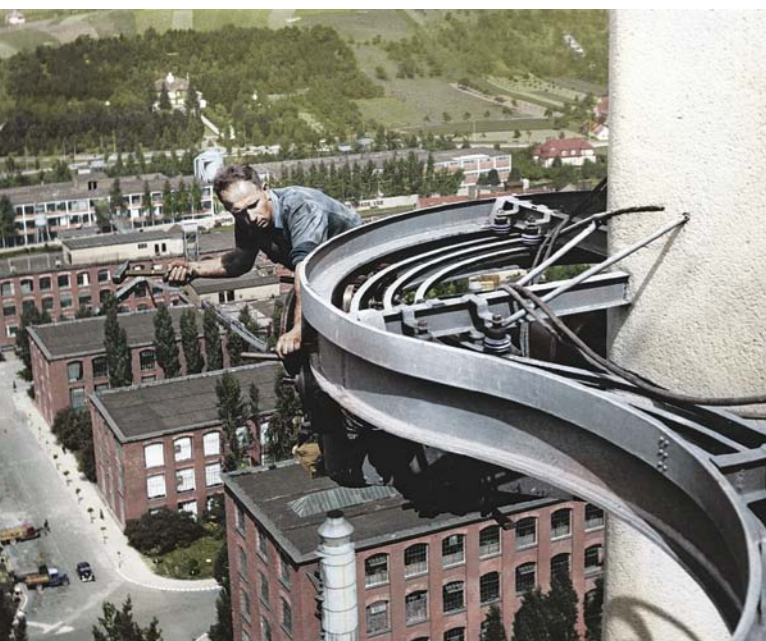
Výstavba 21. správní budovy/Construction of No. 21 Administration Building
